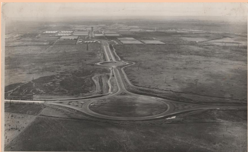
Foto1: Vista aérea do início da construção do núcleo habitacional. Fonte: http://ilhasolteiraambiental.blogspot.com.br/2010/06/registro-fotografico-ilha-solteira-no.html
