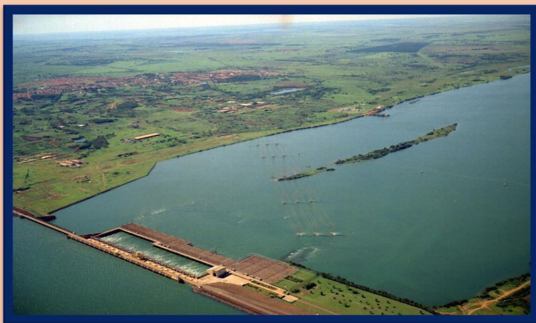
Foto 3: Usina Hidrelétrica de Ilha Solteira, próxima à usina no centro do rio a Ilha que deu o nome à cidade. Fonte: http://ilhasolteiraambiental.blogspot.com.br/2011/04/ilha-solteira-do-rio-parana.html
